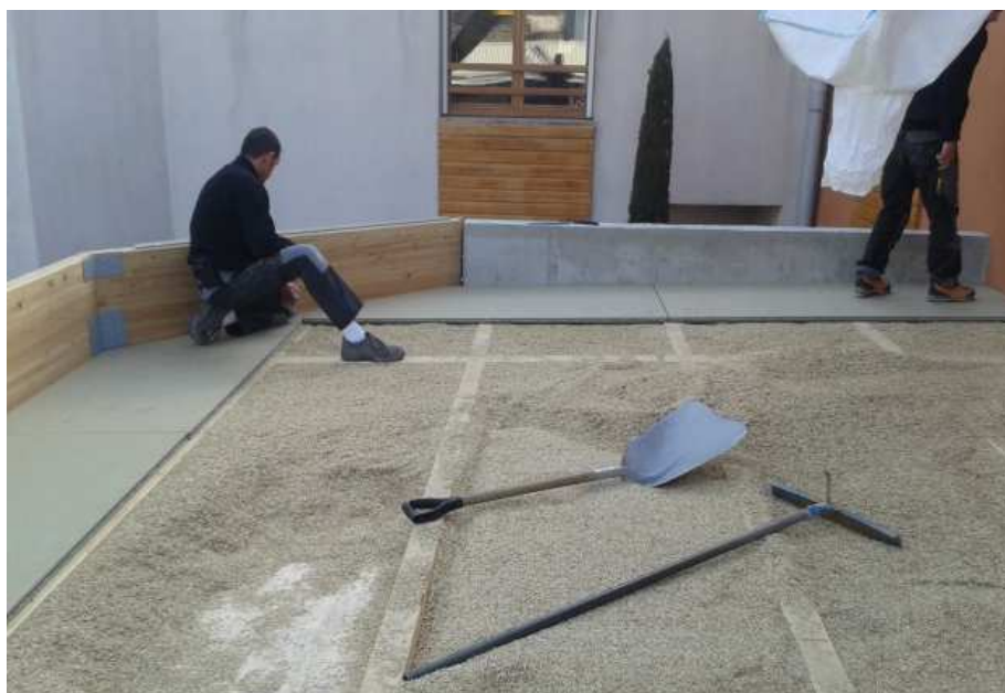
Exemple d'isolation par épandage (Plancher vue en coupe et réalisation)
