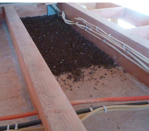
Isolation de plancher
