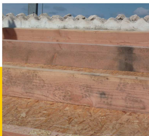
Isolation de toiture
